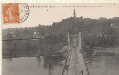
Travaux sur les ponts (Carte postale) - C. PIRON
