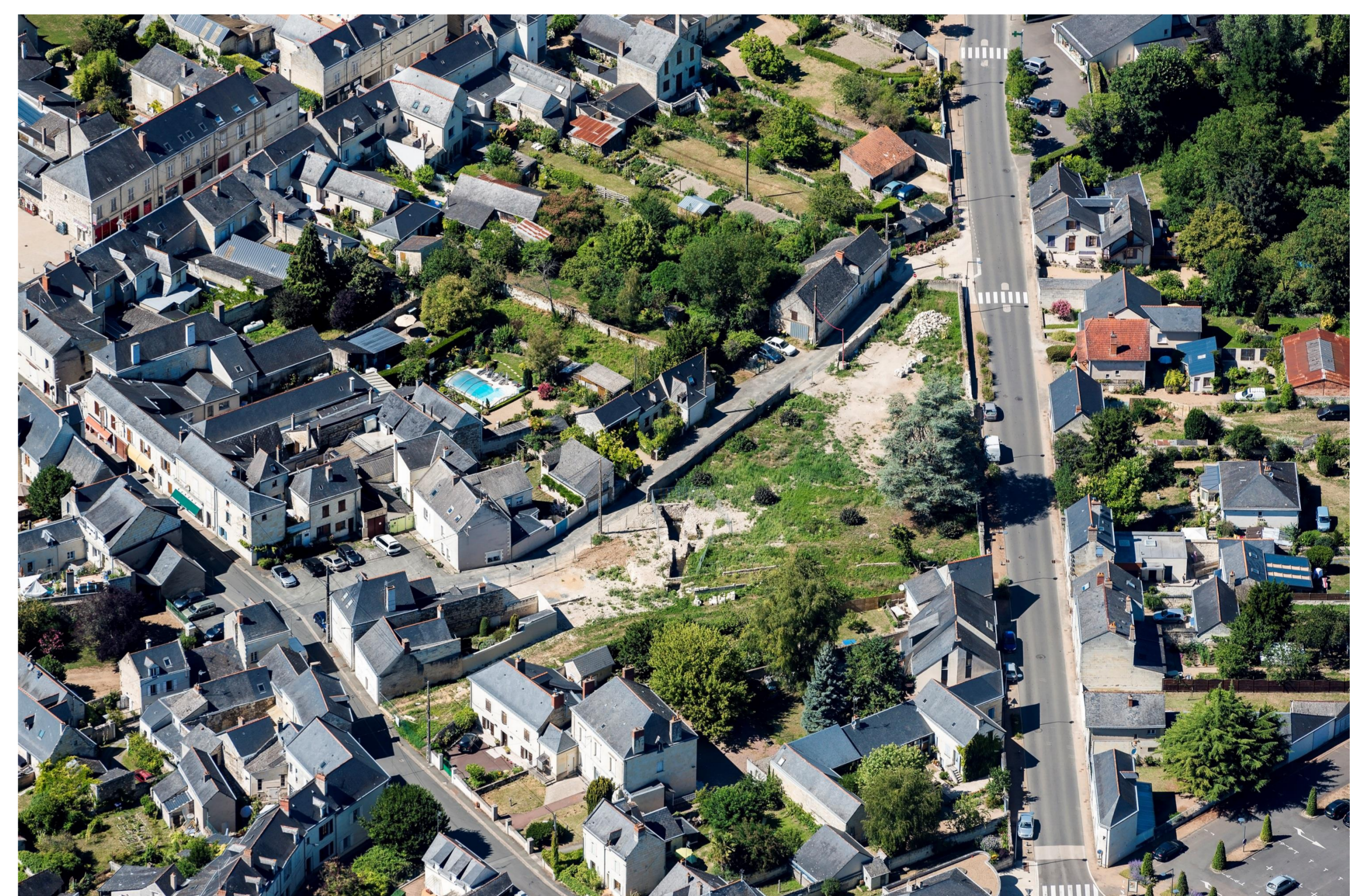
Photo aérienne prise en 2017, après réalisation des travaux de démolition sur une partie du site
